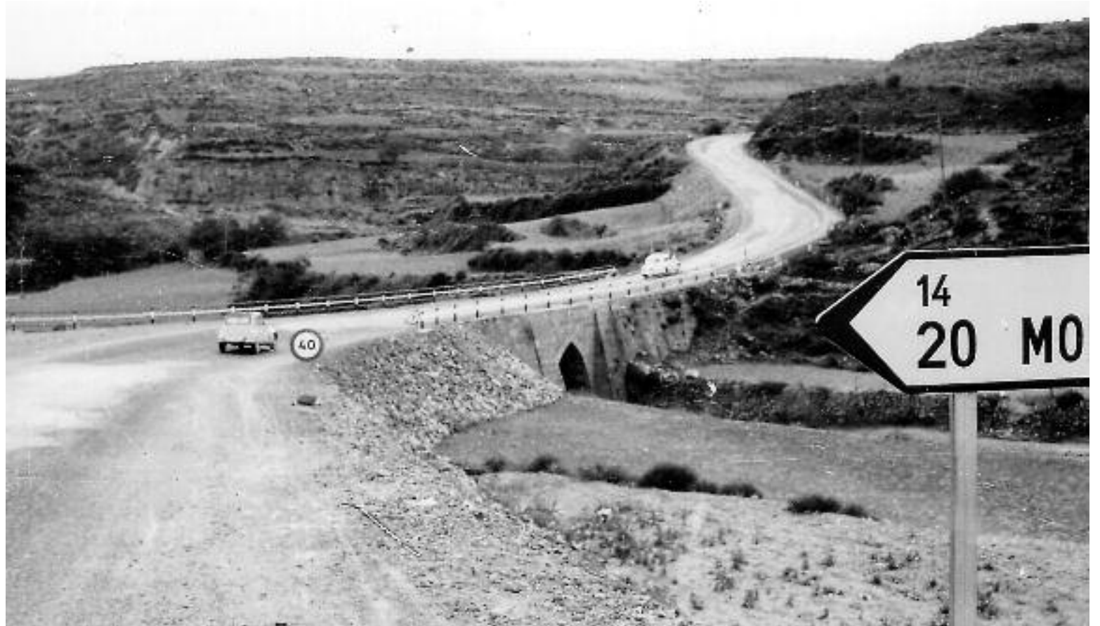
Carretera N-234 hacia 1965 (La Puebla de Valverde). El transporte terrestre necesitaba adecuar el territorio a sus necesidades. El "40" y el cartel de la derecha se llamaban señales de tráfico.
